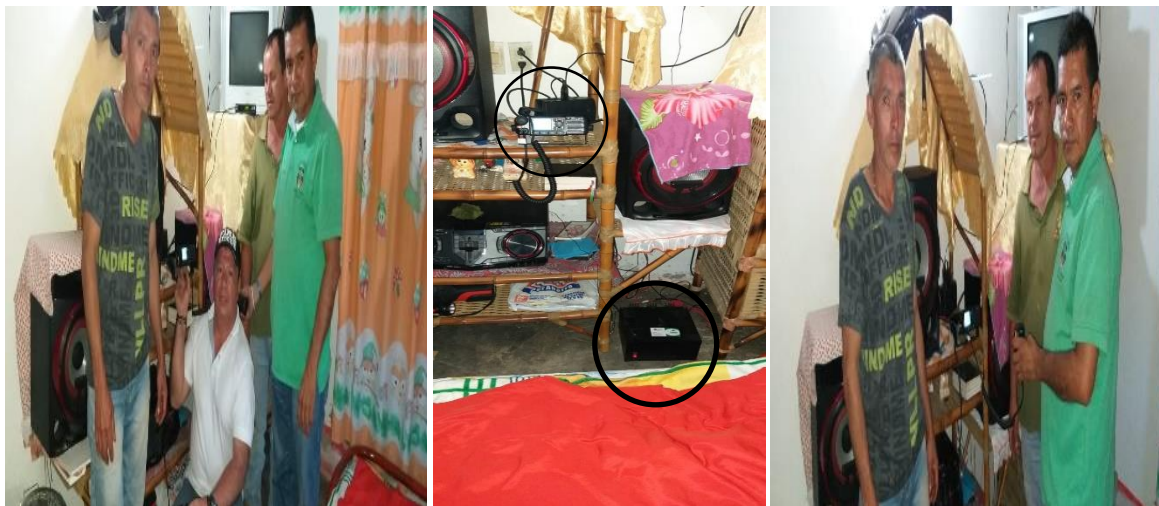
Equipo instalado en el corregimiento de San Fernando – Líbano Tolima
